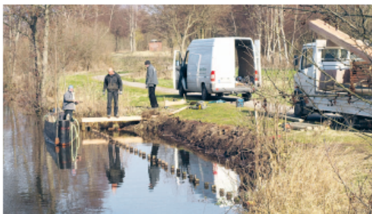
Der alte Steg ist entfernt, noch vor Ostern soll der neue Steg mit Kanueinsatzstelle aufgebaut sein. Foto: jpw
