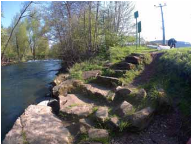
Einsatzstelle in Bad Kissingen
