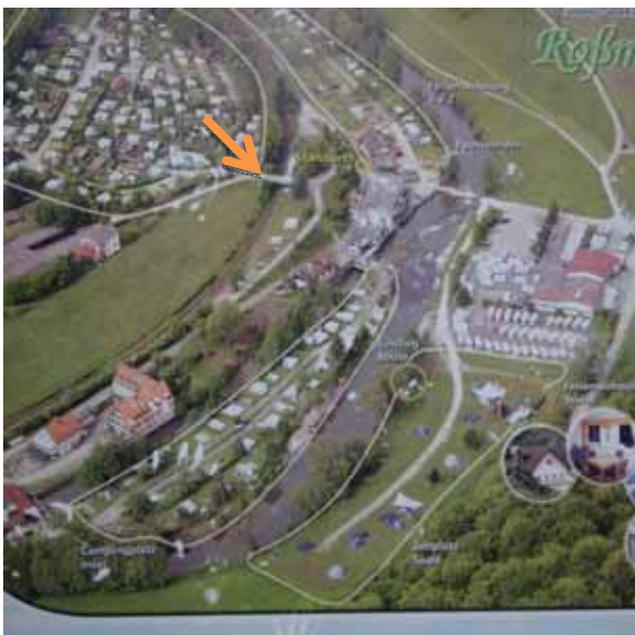
Die Wehranlage Roßmühle
